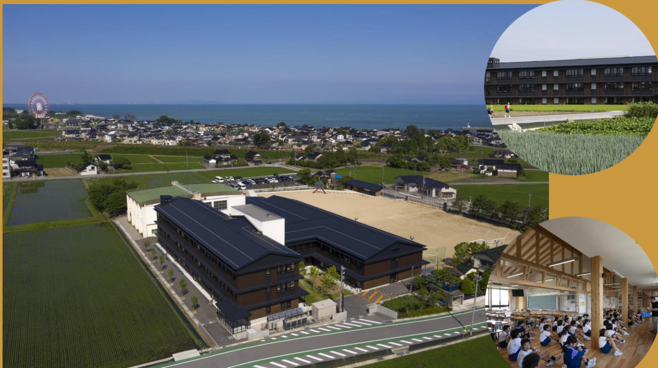
魚津市立星の杜小学校(全国初のオール木造の3階建て小学校) 設計・写真:東畑建築事務所・鈴木一級建築士事務所設計共同体
